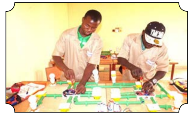
● Travaux pratiques des jeunes en électricité-bâtiment
