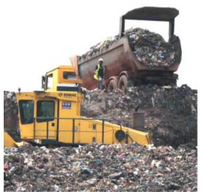
Centre d'enfouissement technique d'Aképé (Image : DAGL)
