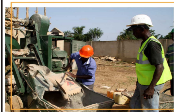
Des maçons sur un chantier
