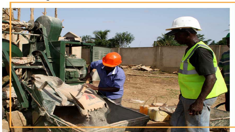
Activités de construction
