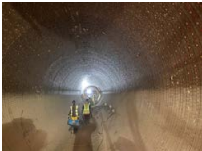
Nettoyage des déchets dans le four après briquetage
