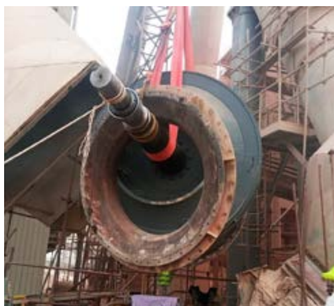
Remplacement de la turbine du ventilateur de tirage du broyeur cru
