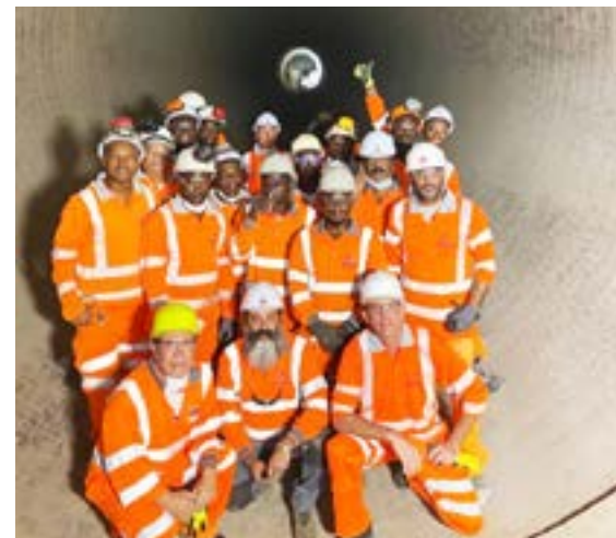
Le DG Eric Gougnac et ses collaborateurs ici lors des travaux dans le four
