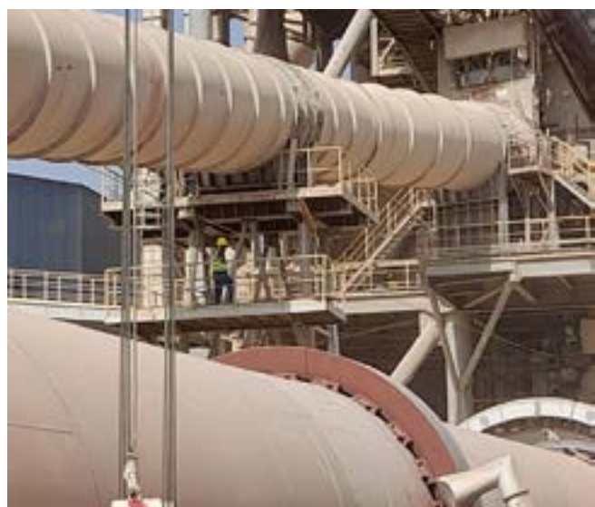
Démontage des échafaudages sur la conduite d'air tertiaire
