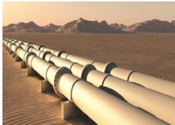
Un gazoduc (canal d'acheminement du gaz)
