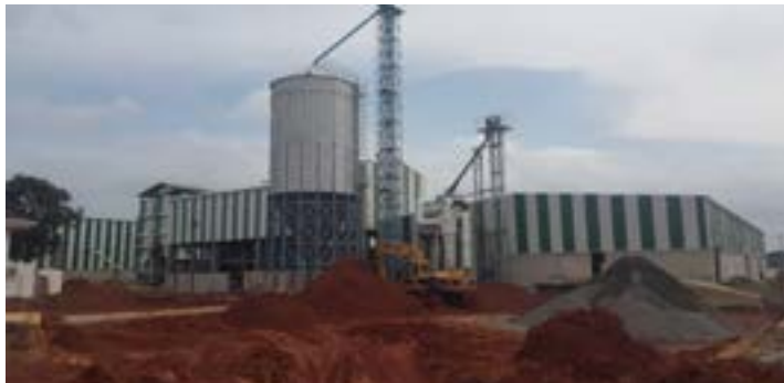
L'usine de transformation en construction
