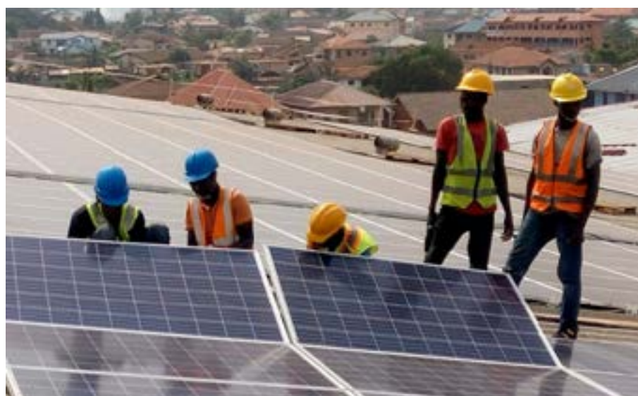
Installation de panneaux solaires
