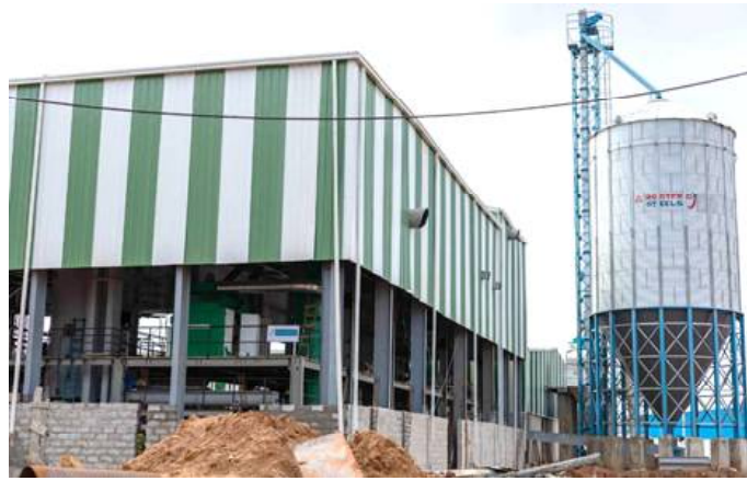
Une vue partielle de l'usine de transformation de soja en construction
