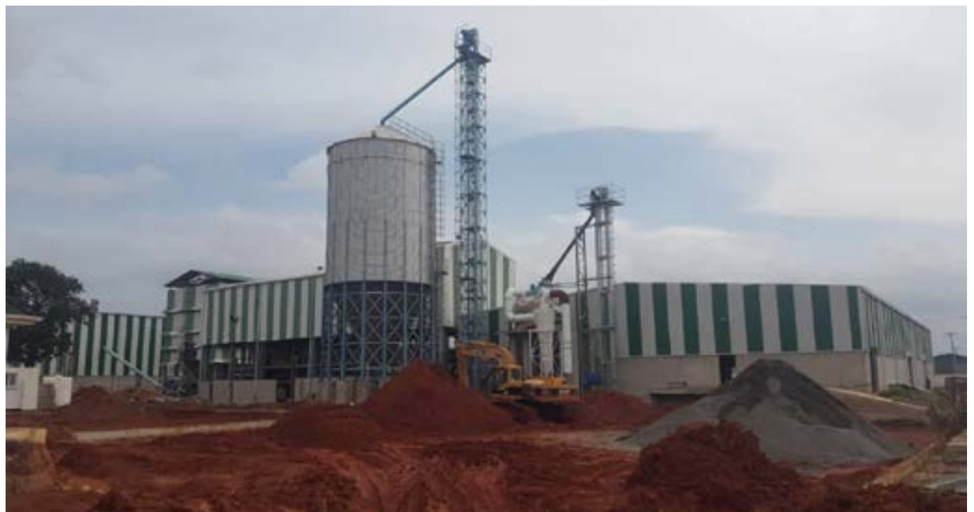
L'usine de transformation en construction
