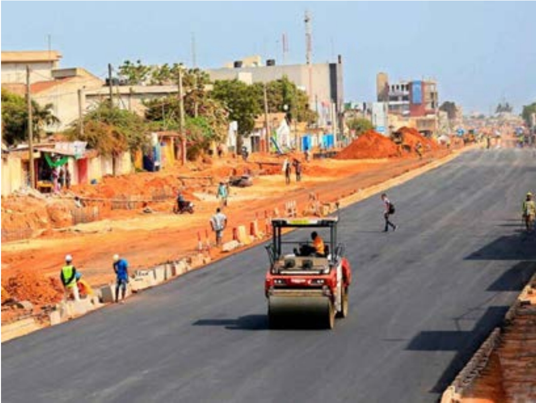
Une route en chantier au Togo
