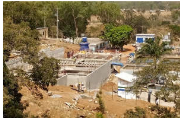
Le chantier du barrage de dédoublement à Kara
