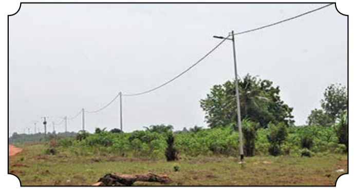
● Travaux d'extension du réseau électrique
