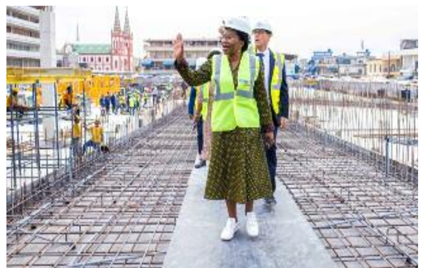
La PM sur le chantier du grand marché de Lomé
