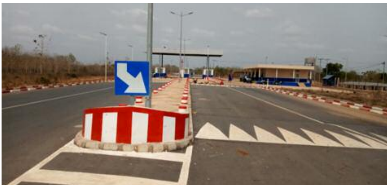
Péage non encore automatisé de Notsè
