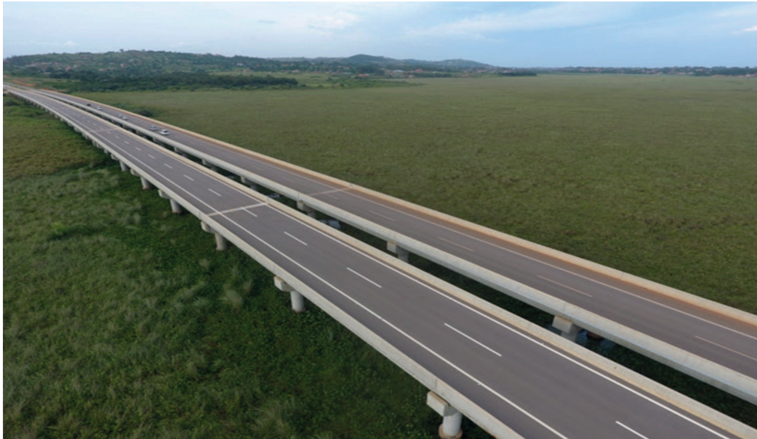
Ici une infrastructure routière en Ouganda qui désenclave une partie du pays
