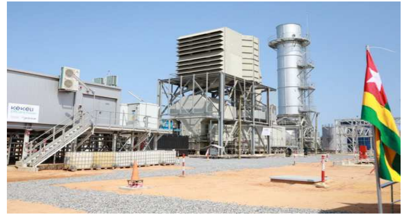
Une vue de la centrale
