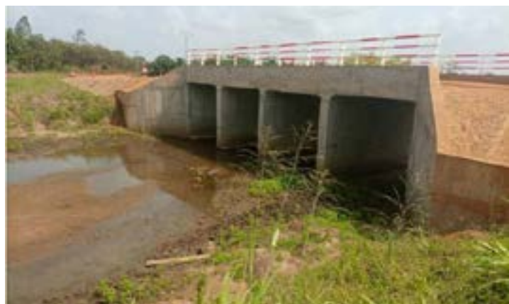
Exécution des travaux de désenclavement dans les cinq régions du Togo
