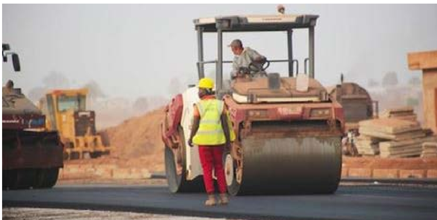
Route communautaire en construction
