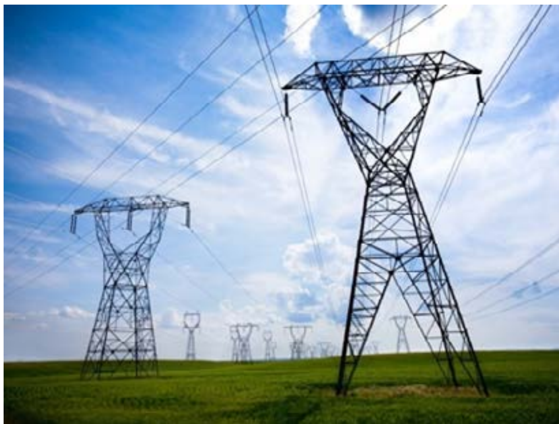
Hautes tensions d'énergie électrique
