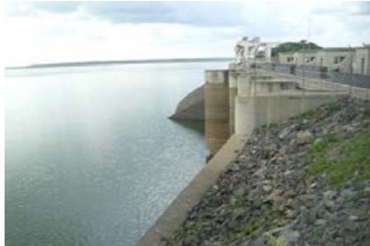
Centrale hydroélectrique de Nangbéto
