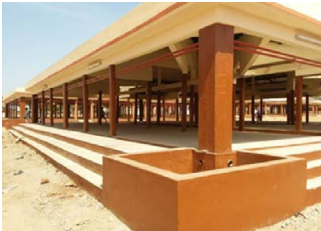
Construction de marché
