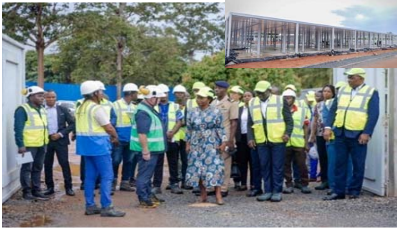
La délégation du PM Dogbé sur un chantier
