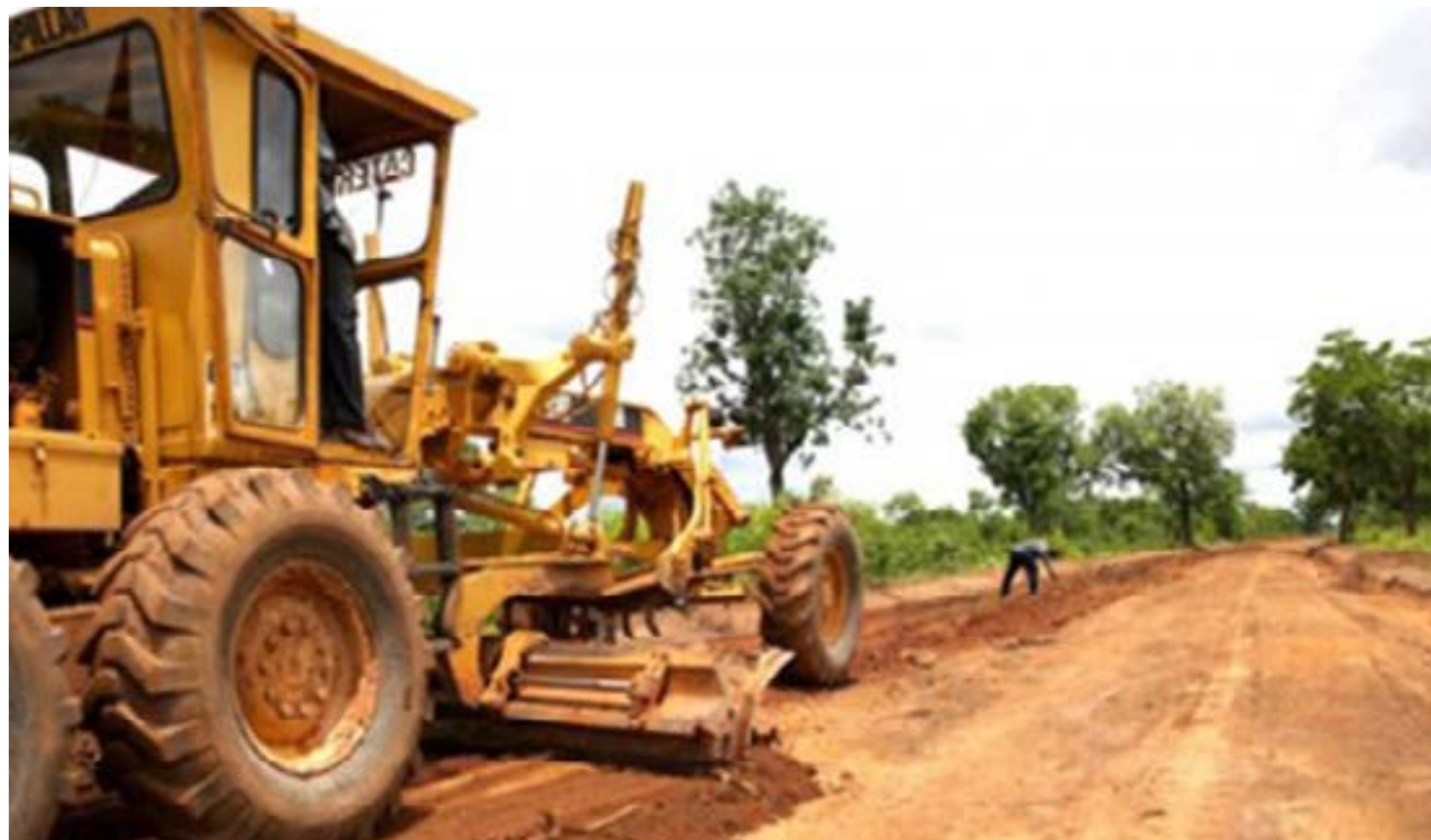
Construction d'une piste rurale
