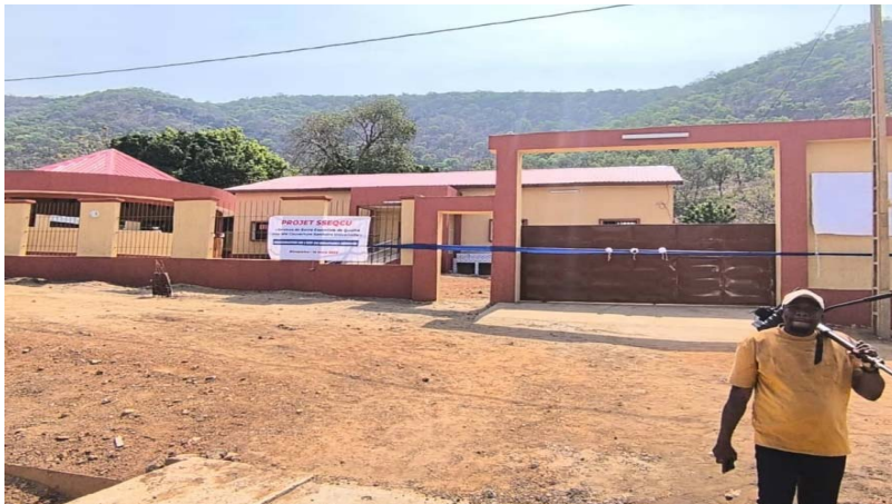
Centre de santé de Binaparba
