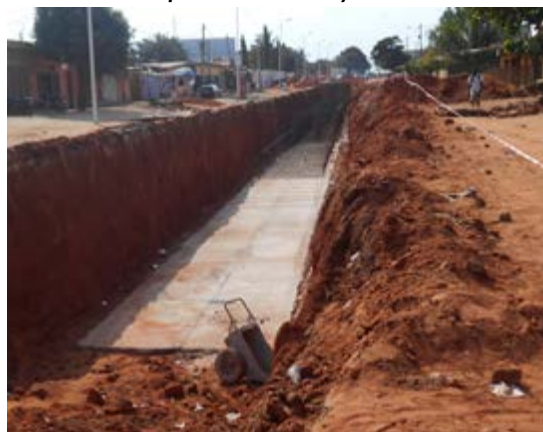
Une route en chantier à Lomé
