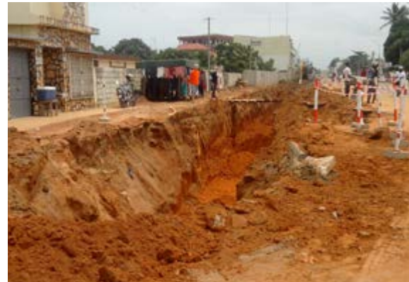
Vue des travaux sur le boulevard de la paix
