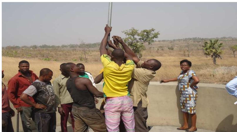
Travaux de construction d'un forage à Awandjé
