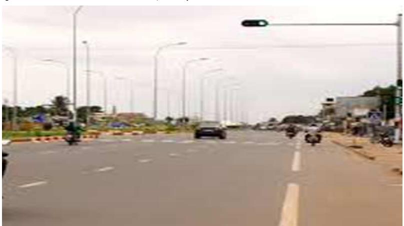
La route en rase agglomération
