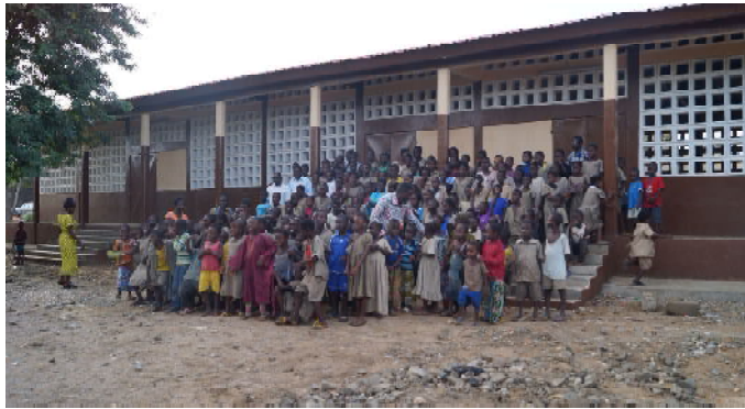
Nouveau bâtiment scolaire Epp COFAC 2
