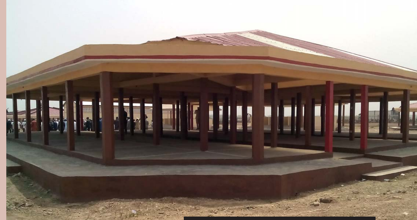
Vue partielle des hangars modernes du nouveau marché
