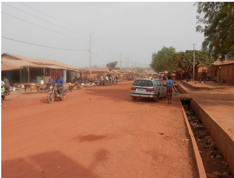
Vue partielle de la route Kérou à aménager
