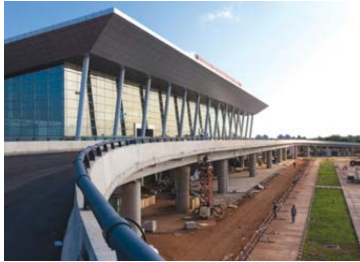
Le chantier de la nouvelle aérogare
