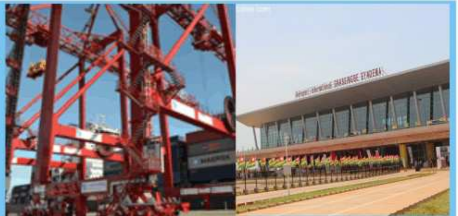
Les portiques du 3ème quai et la nouvelle aérogare de Lomé
