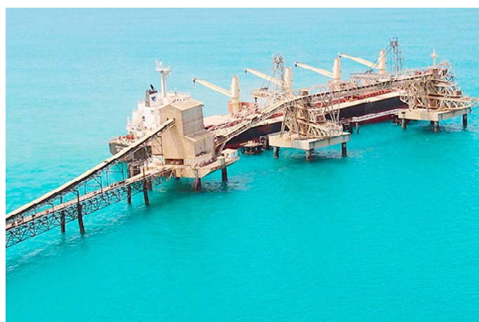
Une vue du wharf de la SNPT à Kpémé
