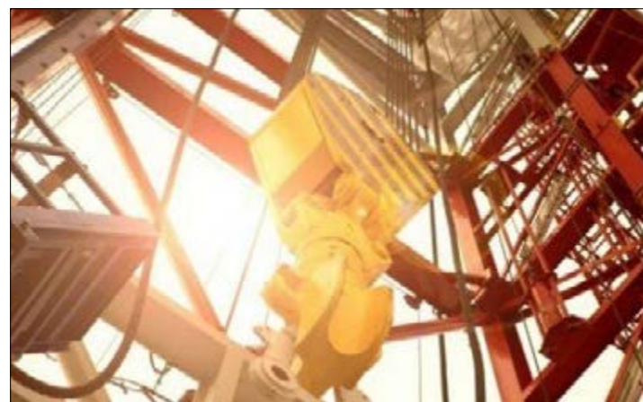
Travaux de construction d'un puits d'exploitation de pétrole
