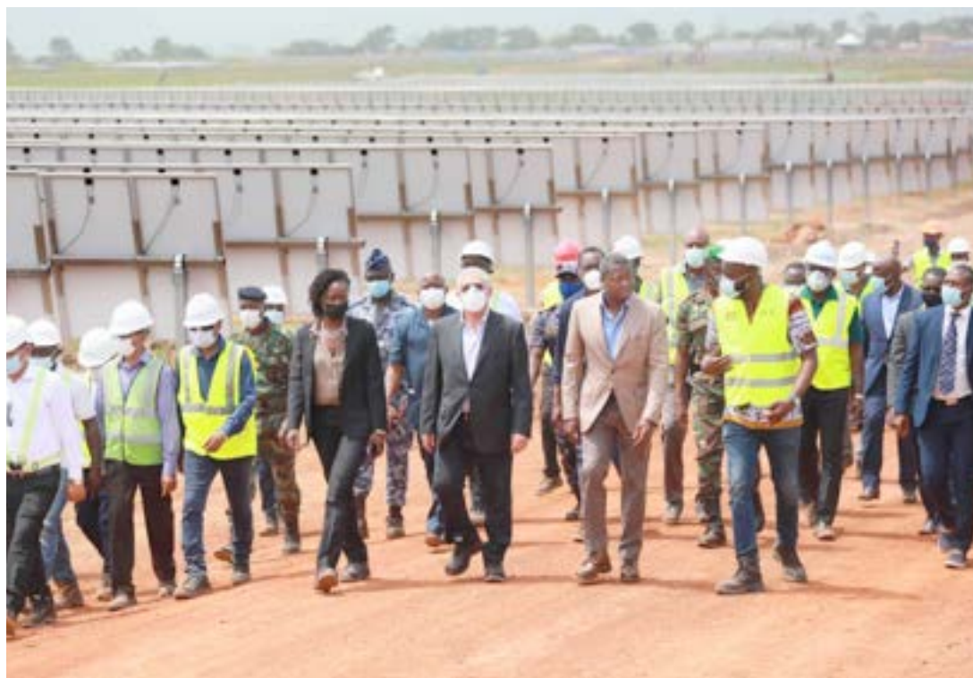
La délégation présidentielle et les ouvriers sur le chantier
